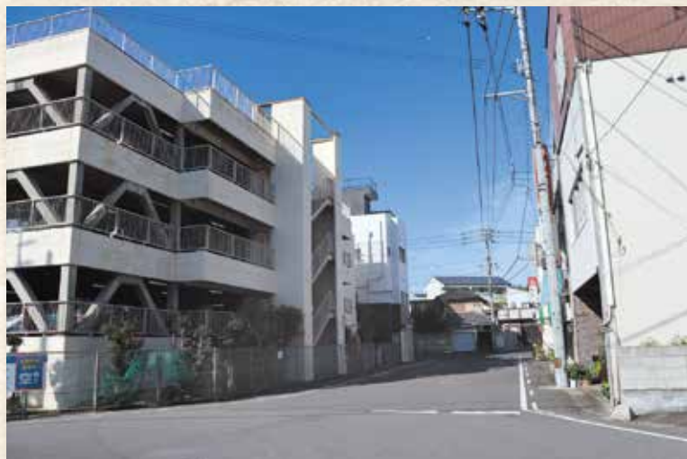
埋め立て後の福島港界限
