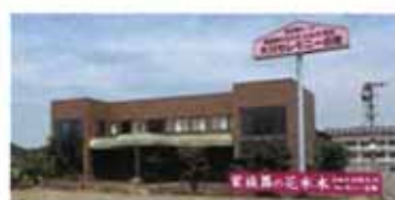
さぬき河田大川セレモニー会館 香川県さぬき市大川町富田西2918-2
